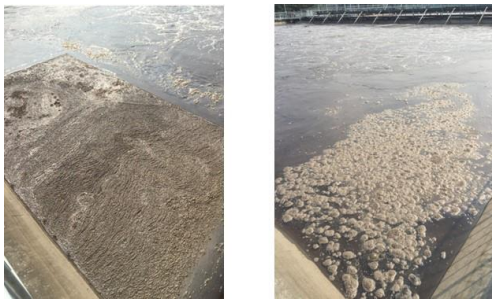
Gambar 7 Kondisi :Lumpur Mengambang Di Unit Aerasi
