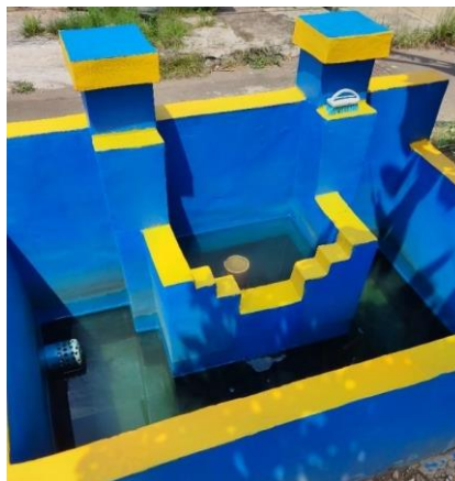
Gambar 14. Unit Bio Indikator
