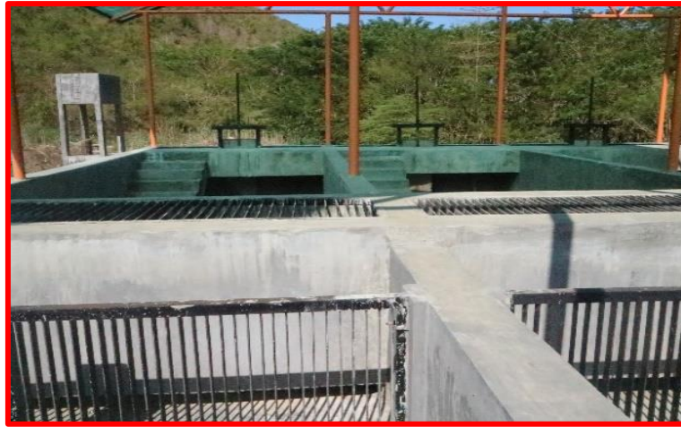
Gambar 5. Bak Separation Solid Chamber (SSC) IPLT Kab. Sumbawa Barat
