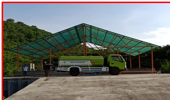
Gambar 4. Tampak Depan Bangunan SSC IPLT Kabupaten Sumbawa Barat
