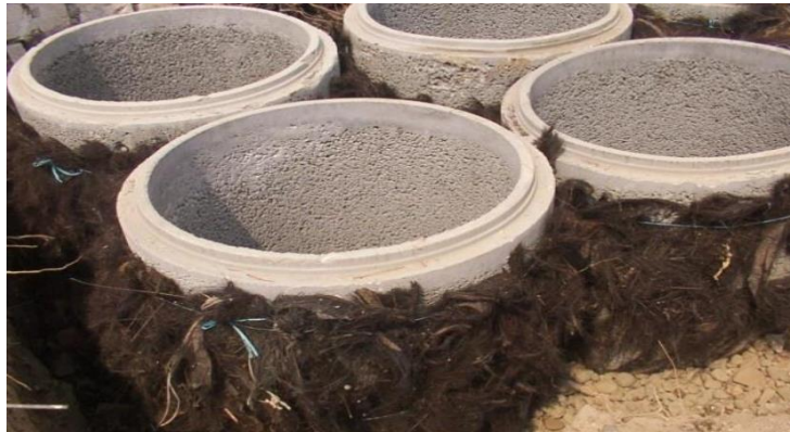
Gambar 8 : Pemasangan Sumur Resapan secara Paralel
