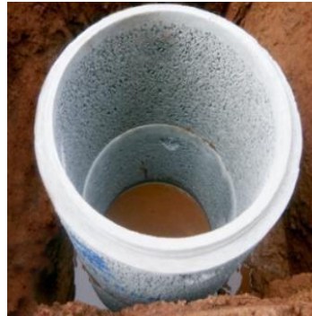
Gambar 6 : Type Sumur Resapan Beton Precast
